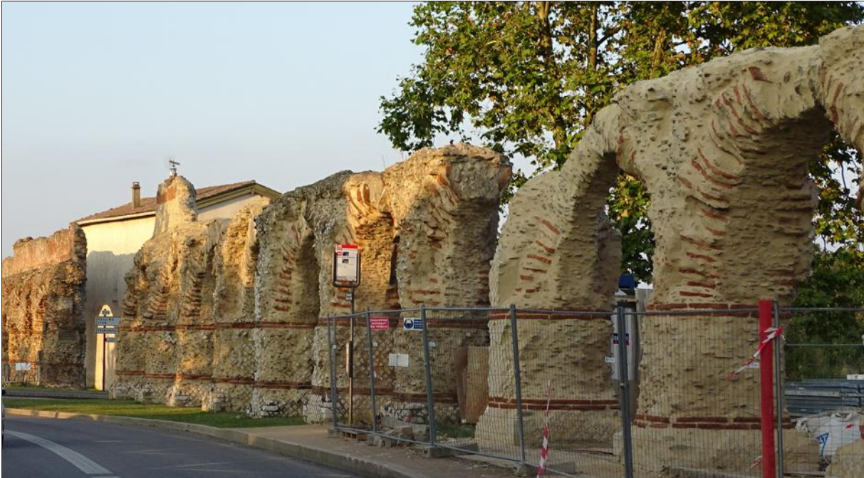
■ Les travaux de restauration des six arches soumis à souscription touchent à leur fin. Les échafaudages ont été retirés la semaine dernière. Photo Claire CHALANDON
